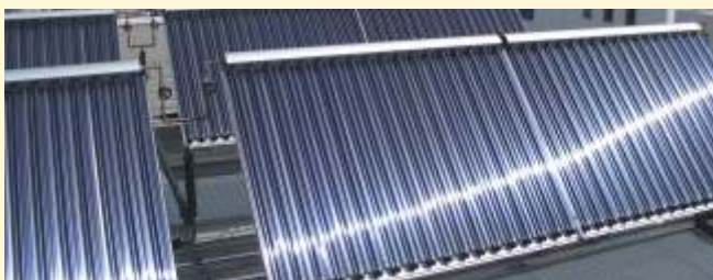
Instalação de coletores de tubo de vácuo LATENTO sobre o telhado do Parque de Diversões Playmobil em Malta
